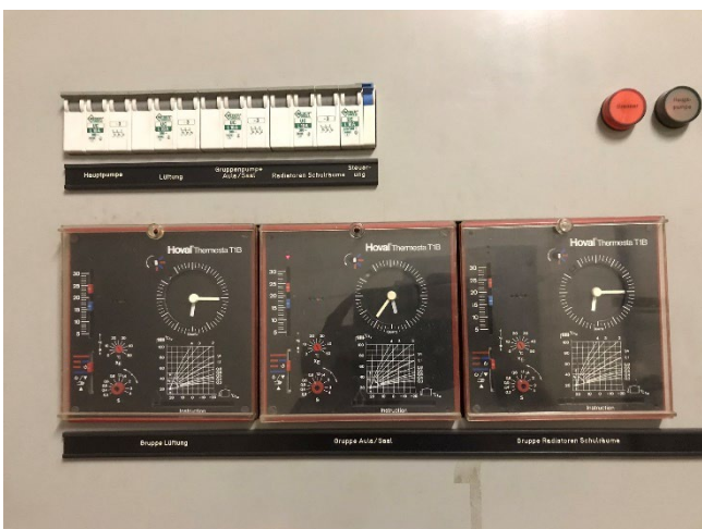
Steuerung Zeitschaltuhren
